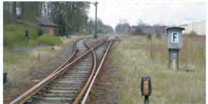
Foto 2: Bahnhof Dahlenburg, Weiche & Signale Intakte Infrastruktur für Zugkreuzungen im 1h-Takt
