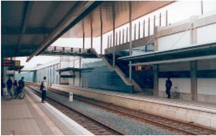
Blick auf den Bahnsteig des fast komplett überdachten Tiefbahnhofes
