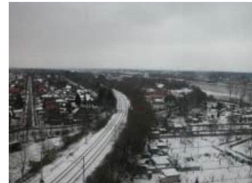
Immer faszinierend: Blick von der Rendsburger Hochbrücke Foto: Thorsten Brandt
