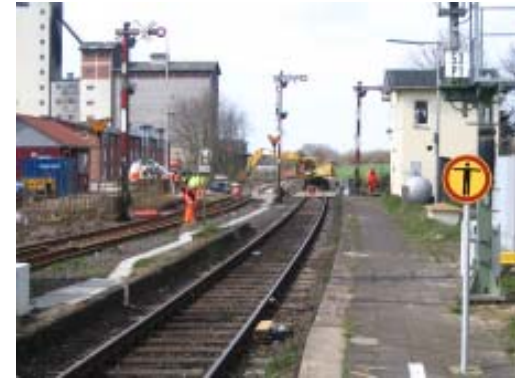
Gleisbauarbeiten im Bahnhof Ratzeburg (Strecke Lübeck - Büchen - Lüneburg) zur Wiederherstellung der Kreuzungsmöglichkeit. Foto: Peter Stoltze
