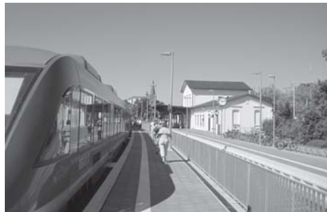
Bahnhof Plön nach dem Umbau
