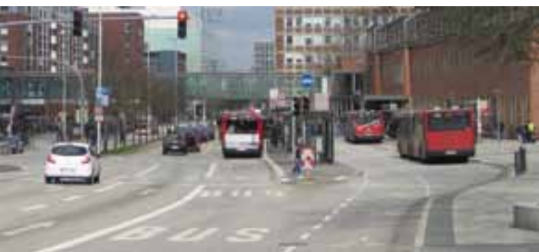
Bushaltestelle Kiel Hbf: Dort soll die SRB-Haltestelle entstehen.
