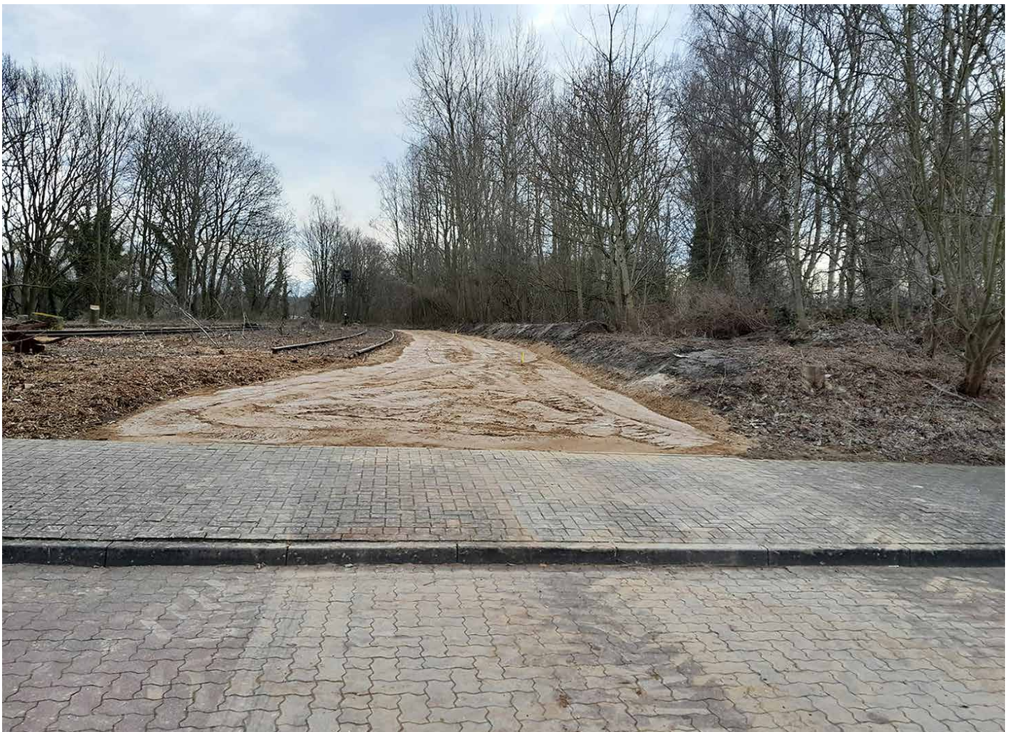
Neubau Zuwegung und Erschließung der Bahnfläche in Lütjenburg.
