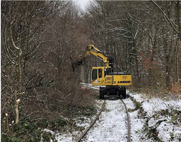
Bild vom Zweiwegebagger zum Freischnitt auf der Strecke Malente-Lütjenburg bei Holsteinische Schweiz im Dezember 2022.
